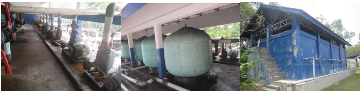
**Gambar 10. Pompa air , filter dan tandon distribusi**
