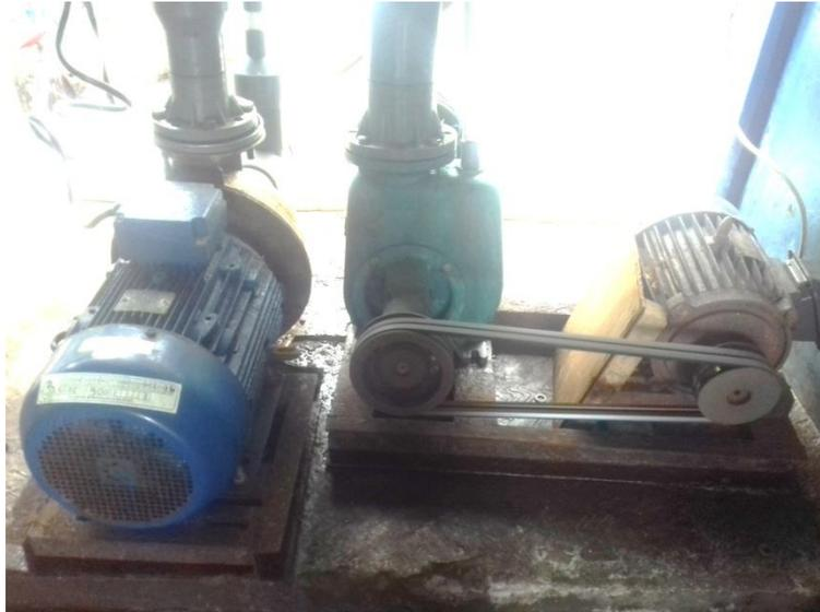
**Gambar 14. Pompa Air Laut**
