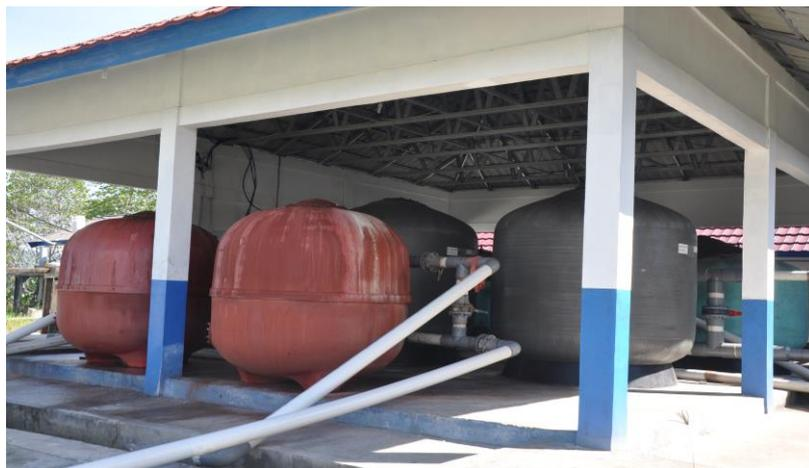
**Gambar 11b. Bak filter sistem tertutup bertekanan**
