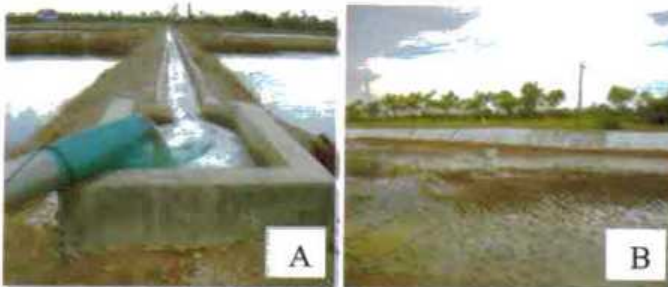
Gambar 2. Saluran pemasukan ke petakan (A) saluran pembuangan tengah (B)
