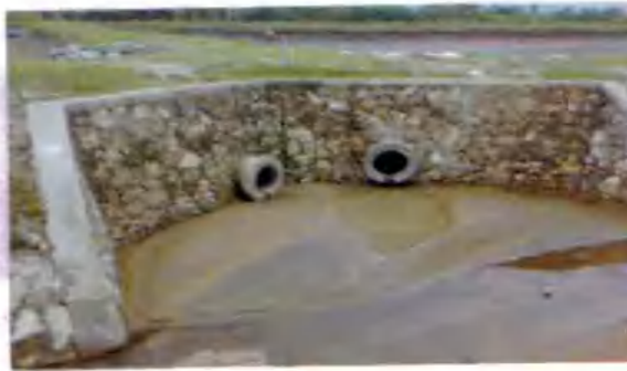
Gambar 3. Saluran pembuangan utama yang juga berfungsi sebagai pintu panen
