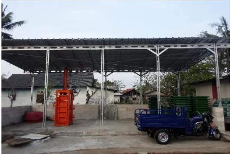
Gambar. bangunan sederhana TPS/PDU
