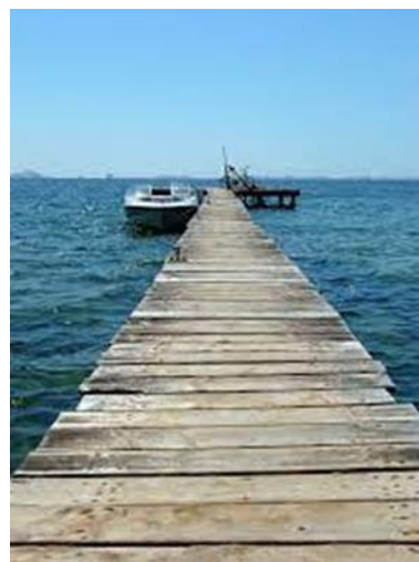
Gambar. Jetty kayu
