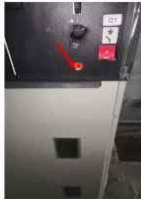
Ket : Gambar kiri tanda panah merah menunjukkan indikator fuse kubikel putus Gambar kanan kondisi fuse putus setelah dikeluarkan dari kubikel
