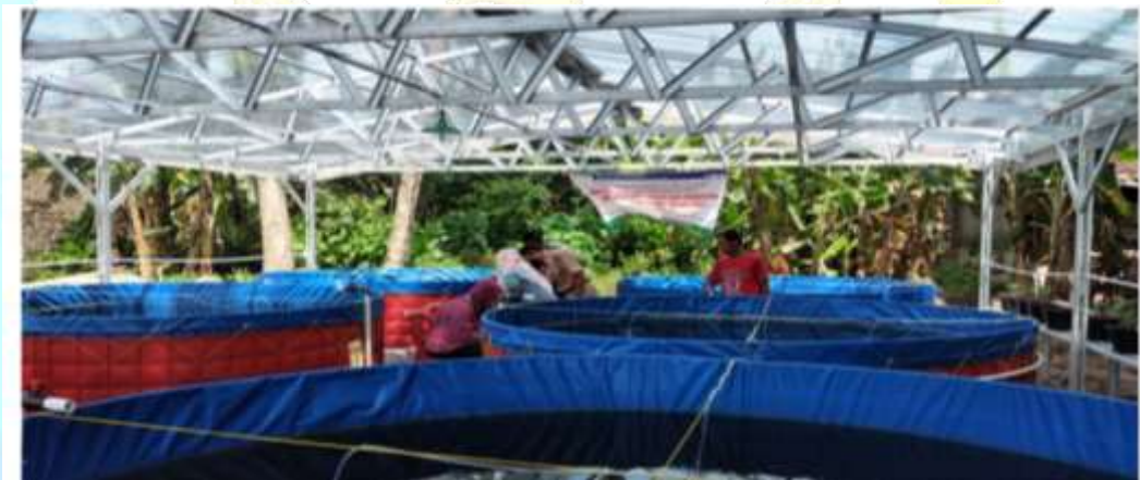
Gambar 37. Hasil Pekerjaan Bantuan Sarpras Ikan Lele Sistem Bioflok di Pokdakan Mina Katon Kabupaten Klaten
