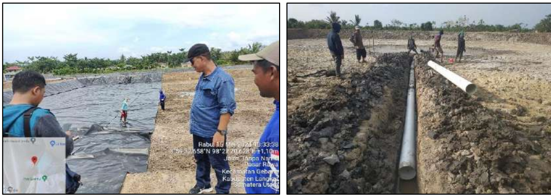
Gambar 7. Proses pemasangan pipa dan plastik HDPE
