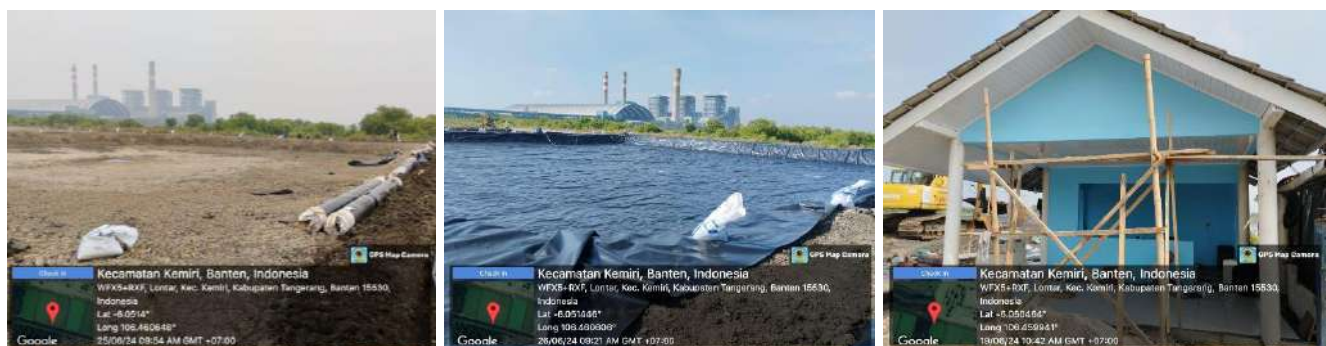
Gambar 10. Proses pemasangan HDPE dan rehab rumah jaga
