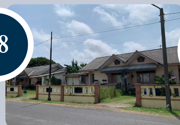
Rumah Negara Blok A, B dan C ; 808 m 2
