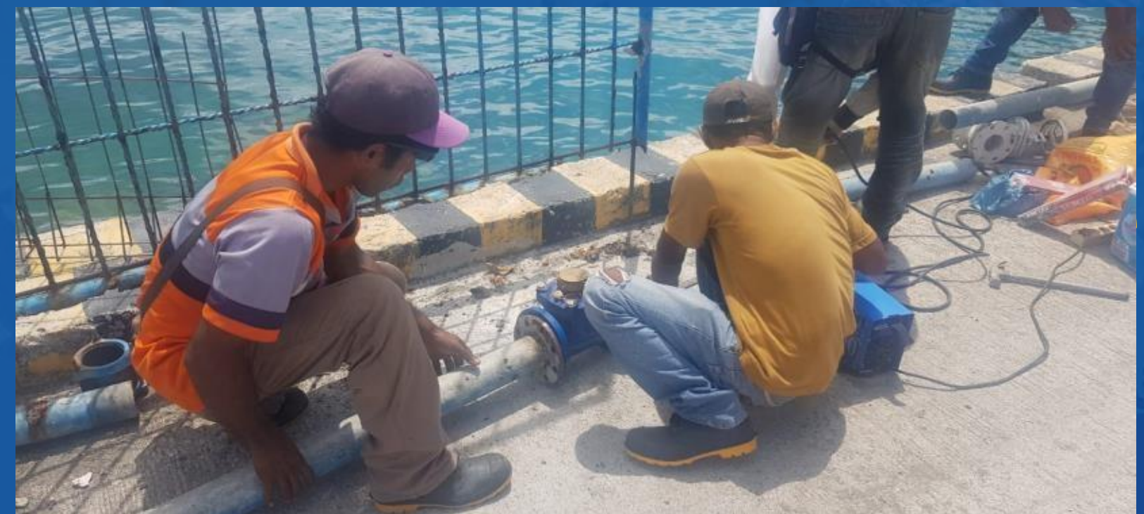
Instalasi Pipa Air Bersih
