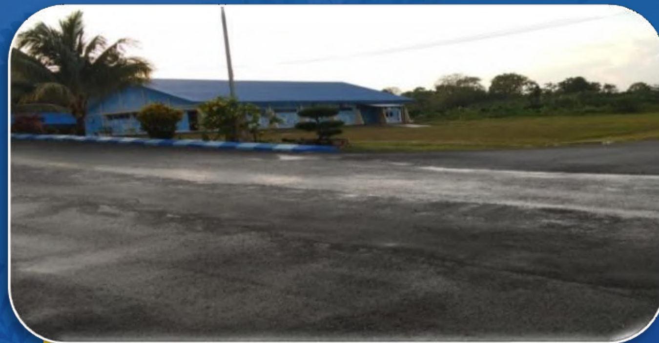
Cold Storage Kapasitas 200 Ton
