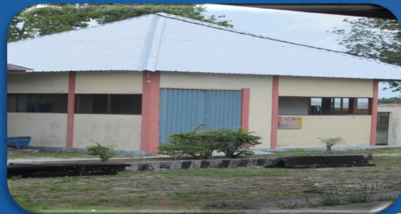
Cold Storage Kapasitas 15 Ton
