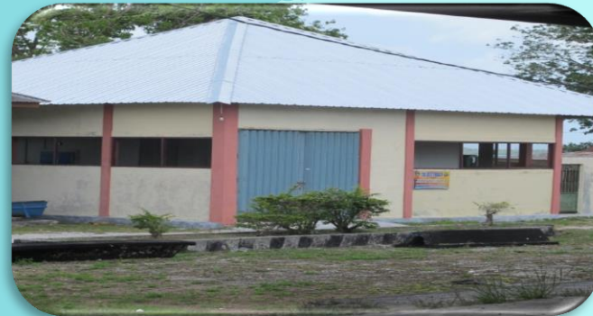
Cold Storage Kapasitas 15 Ton
