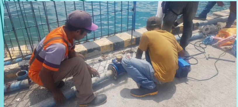
Instalasi Pipa Air Bersih
