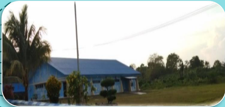
Cold Storage Kapasitas 200 Ton
