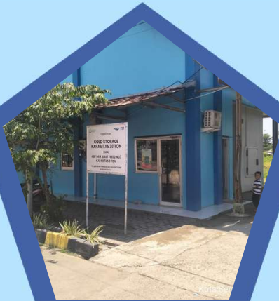
Coldstorage Kapasitas 30 ton
