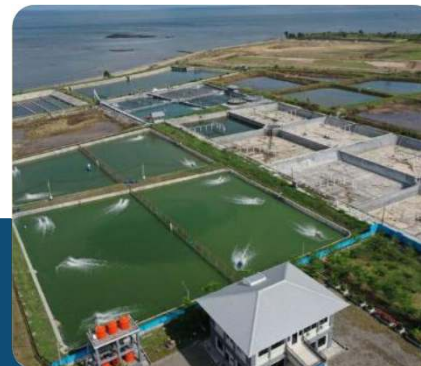
Instalasi Tambak Takalar
