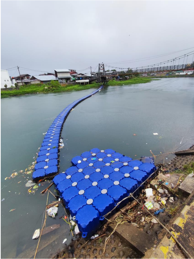
Trash trap (perangkap sampah) yang dipasang di sungai Batang Arau. Sifatnya floating sehingga masih ada celah sampah dari hulu
