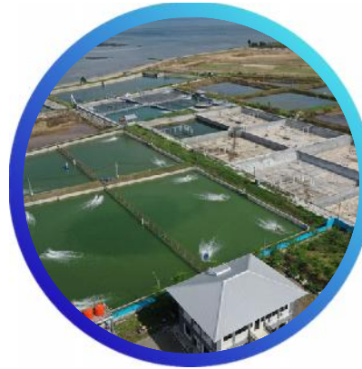
Instalasi Tambak Takalar
