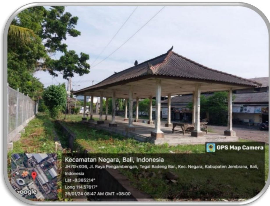
Shelter Nelayan Luas 75 m2
