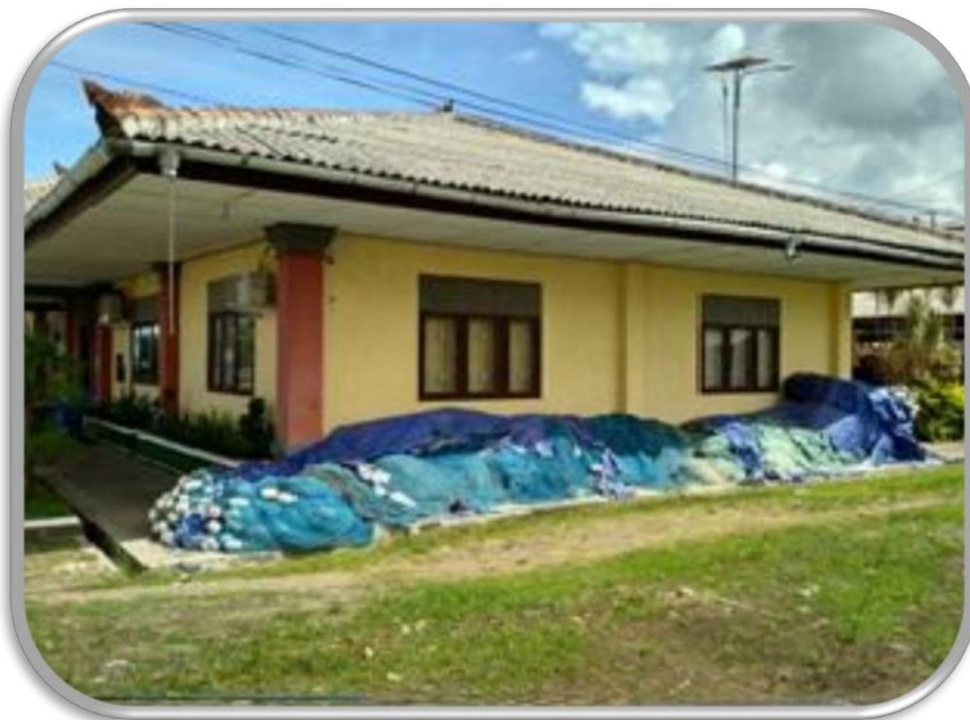
Gedung Kantor 1 Luas 240 m2
