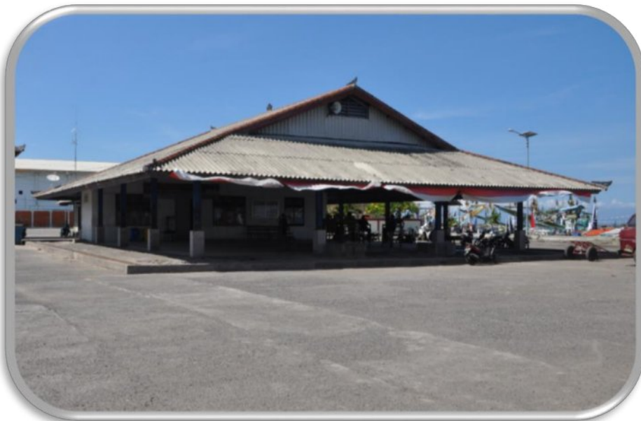
Tempat Pelelangan Ikan (TPI) Luas 320 m 2
