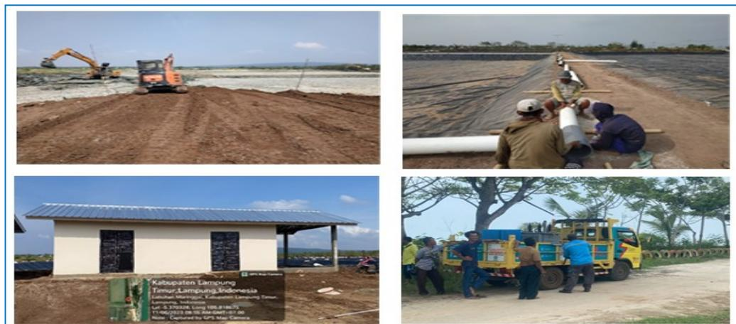
**Gambar 33.** Tahapan pelaksanaan (searah jarum jam) : pembuatan konstruksi tambak, pemasangan *lining* (HDPE), pembangunan gedung fasilitas penunjang, pemasangan listrik)
