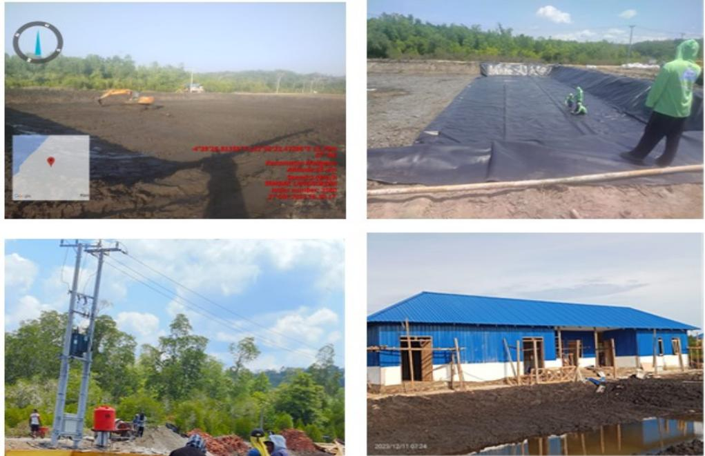
**Gambar 29.** Tahapan pelaksanaan (searah jarum jam) : pembuatan konstruksi tambak, pemasangan *lining* (HDPE), pembangunan gedung fasilitas penunjang, pemasangan listrik)
