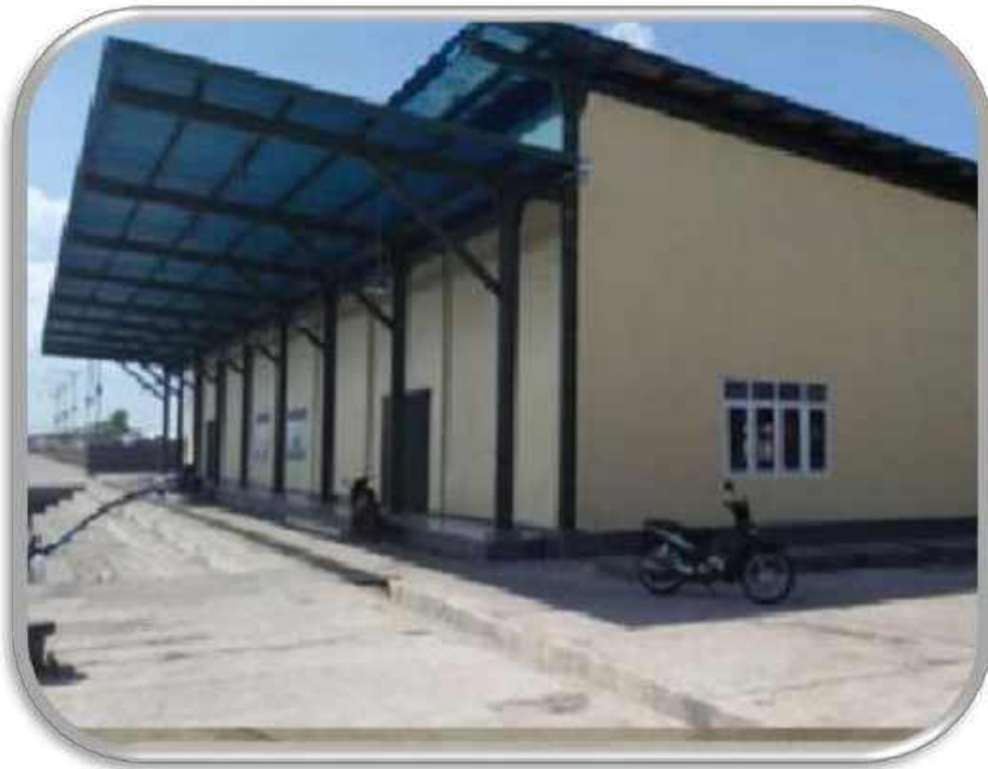
Tempat Pelelangan Ikan (TPI) Higienis Luas 889 m2
