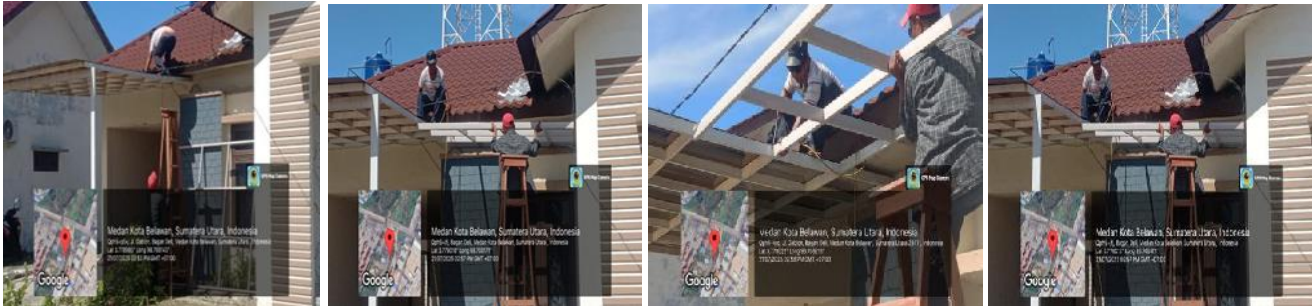
Pemasangan kanopi rumah dinas Kalabuh
