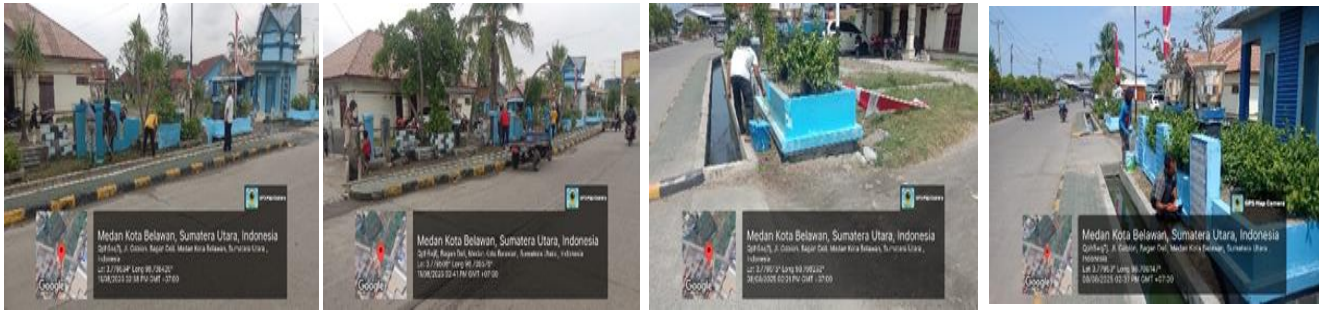
Pengecatan tembok Guest House
