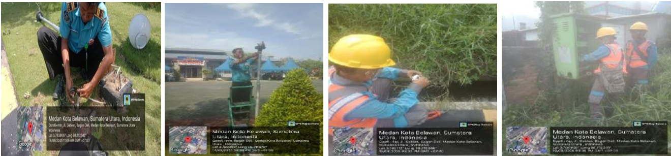
Pemeliharaan lampu taman & Pengecekan arus listrik oleh tim PLN
