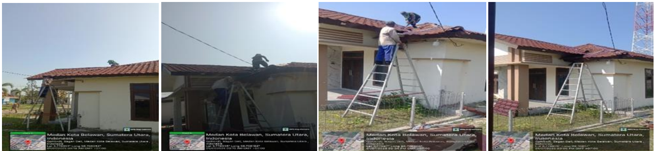
Perbaikan Atap rumah dinas
