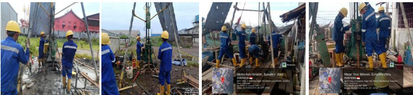
Pekerjaan Pengeboran Tanah Tim Survey Geoteknik
