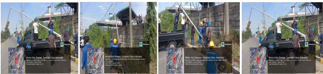
Pemasangan tiang listrik baru
