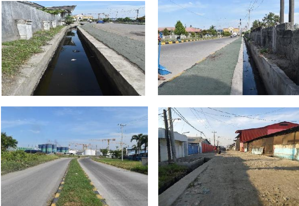
Gambar 44. Jalan dan Drainase
