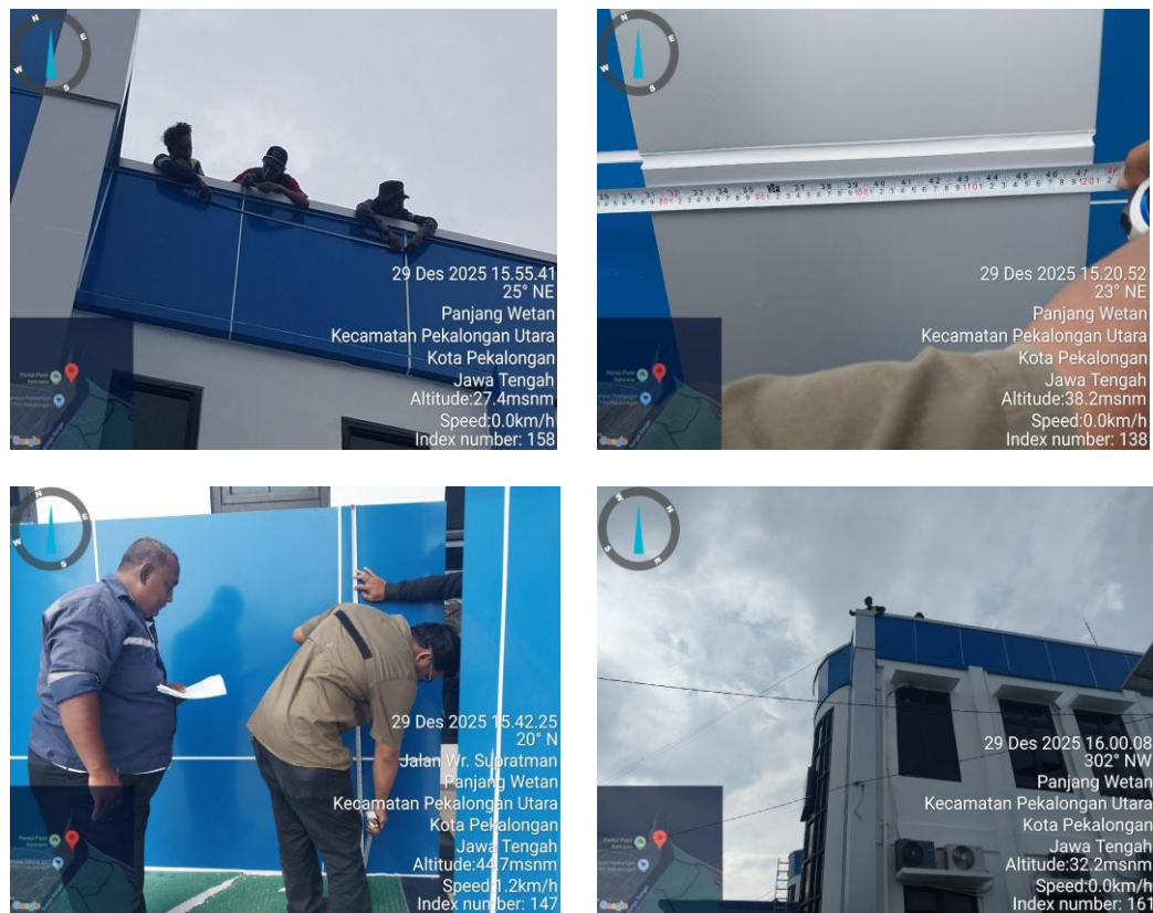
Gambar 14. Pemeliharaan Gedung Kantor
