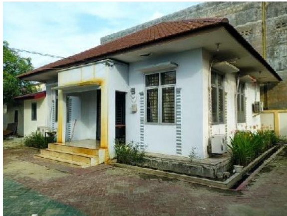
Gambar 13. Gedung dan laboratorium mutu
