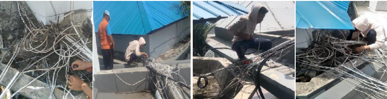
Perbaikan Instalasi Listrik
