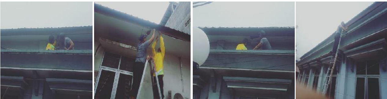
Perbaikan Plafon Luar Kantor PPS Belawan
