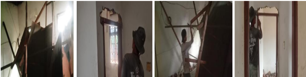
Pembongkaran Plafon dan Kusen Pintu
