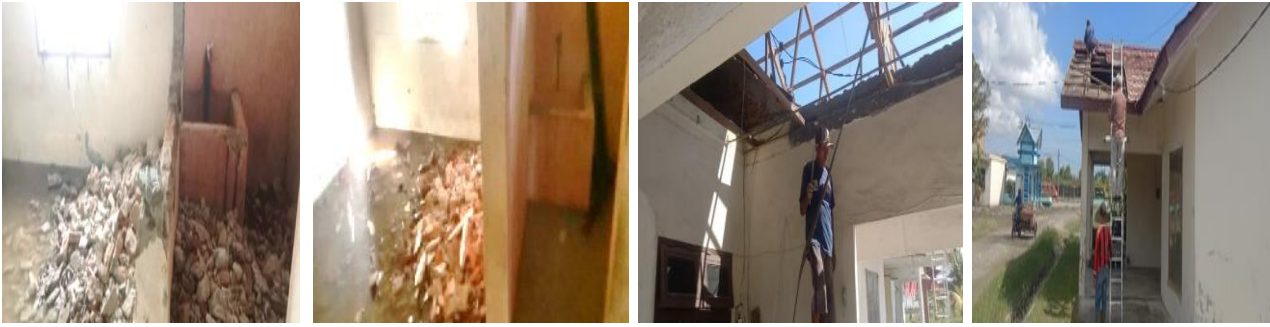
Pemecahan Dinding Tembok Guest House & Penggantian Atap Mess Operator
