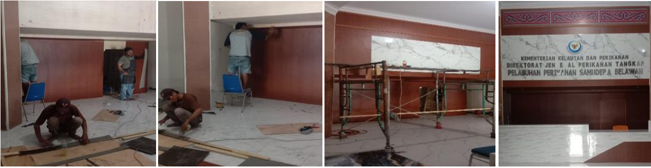
Pemasangan Interior Ruang Lobi
