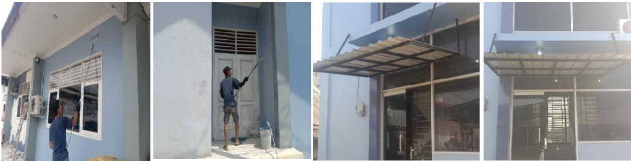
Pengecatan Dinding Kantor Syahbandar & Pemasangan Knopi di Menara Pengawas
