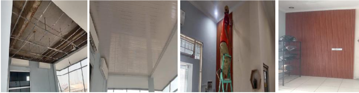
Pemasangan PVC & Pemasangan WPC di Kantor Syahbandar
