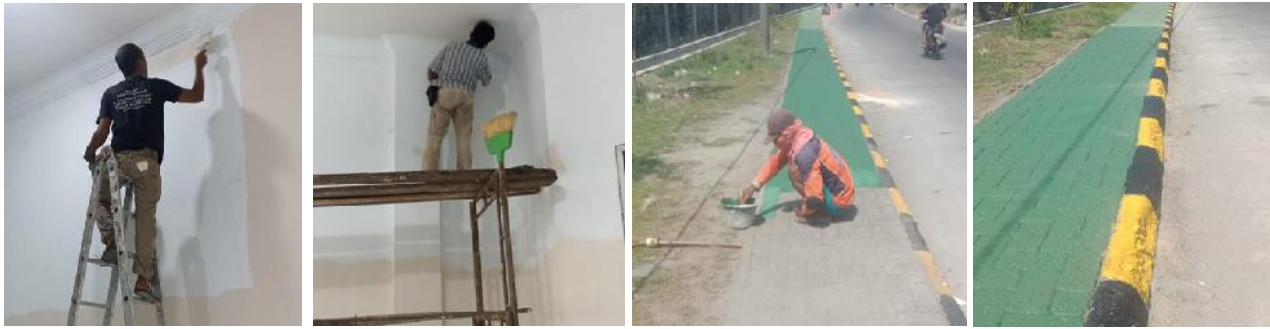
Pengecatan Ruang Lobi & Pengecatan Trotoar
