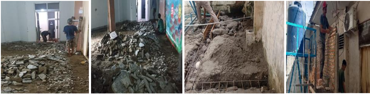
Pemeliharaan Ruang Lobby & Pemeliharaan Toilet Kantor Syahbandar
