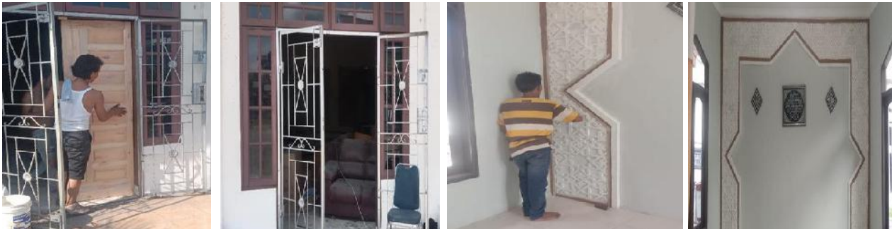
Pemasangan Pintu di Ruang Arsip & Pemasangan Walpaper Musholla PPS Belawan
