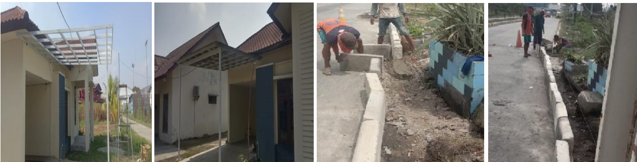
Pemasangan Kanopi di Mess Kepala Pelabuhan & Pemasangan Kanstin
