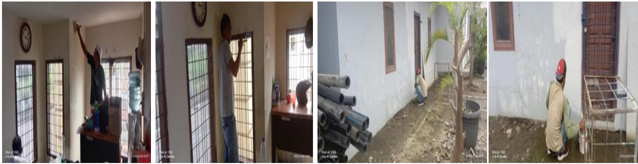
Pengecatan Gudang Kantor Dan Pos Masuk
