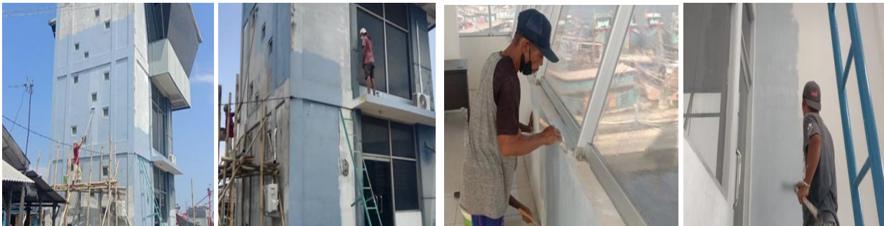
Pengecatan Gedung Menara Pengawas
