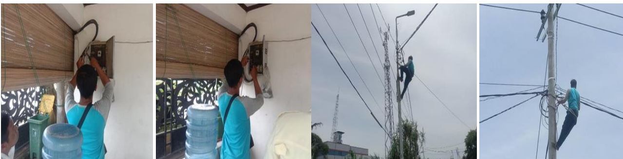
Perbaikan Instalasi Listrik
