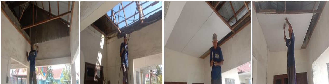
Pemasangan Plafon Di Mess Operator
