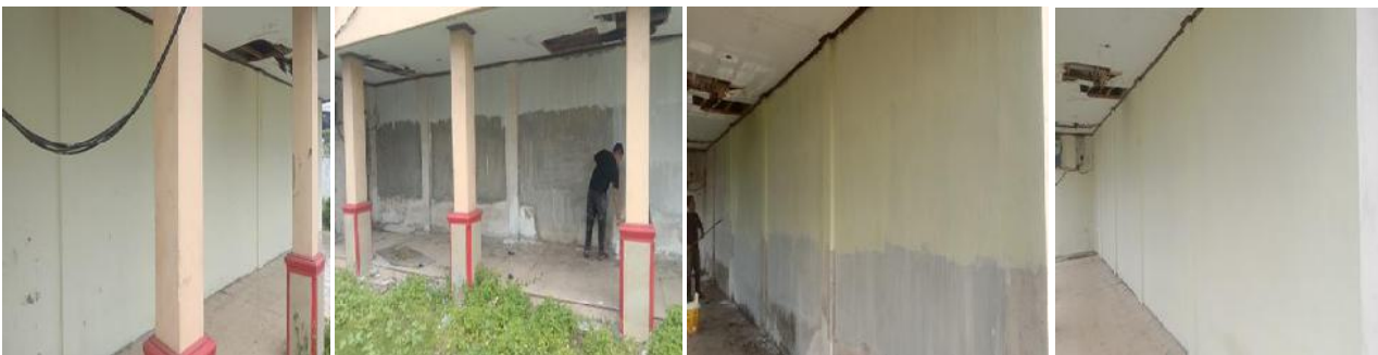
Pengecatan Dinding Ruang Arsip
