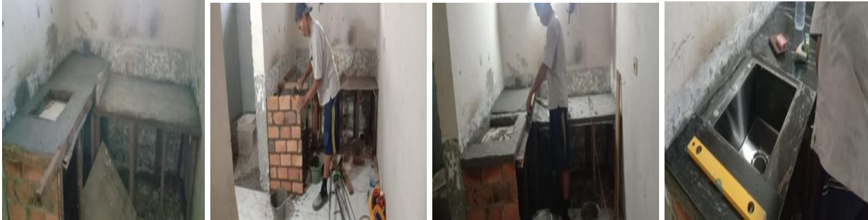
Pembuatan Wastafel Guest House
