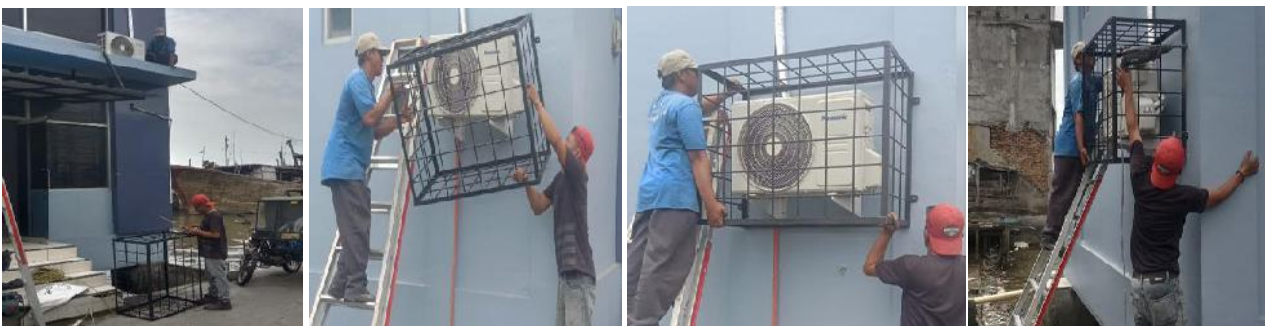
Pemasangan Kerangkeng AC Menara Syahbandar
