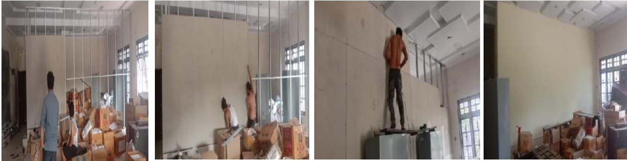
Pemasangan Partisi di Ruang Arsip PPS Belawan
