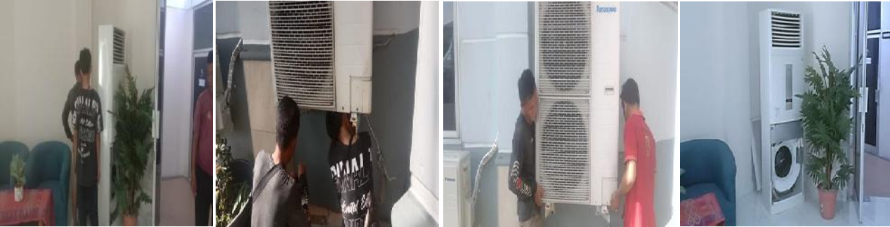
Pemasangan Standing AC
