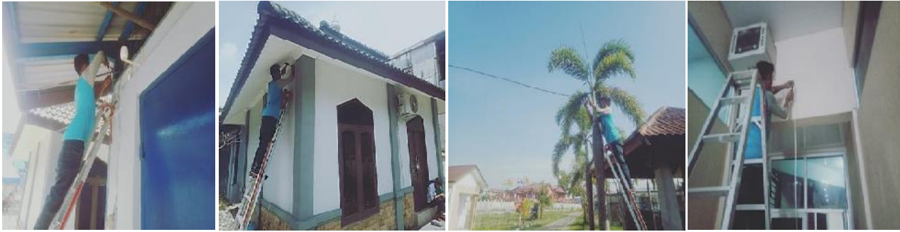
Pemasangan Instalasi CCTV
