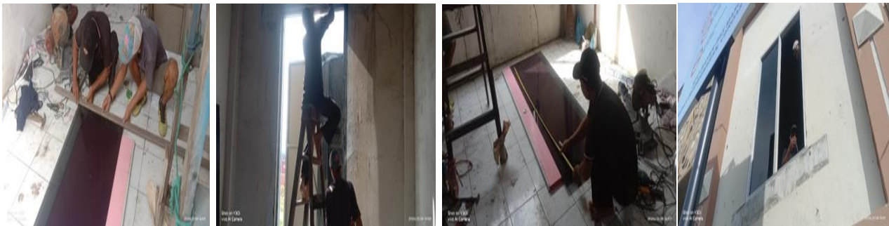
Pemasangan Jendela Kaca di Pos Masuk
