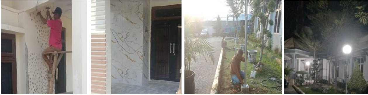
Pemasangan Keramik di Mess Kepala Pelabuhan & Pemasangan Lampu Kantor di PPS Belawan
