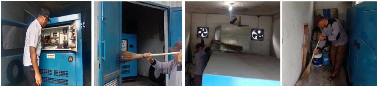
Pemeliharaan Jaringan Listrik/Genset
