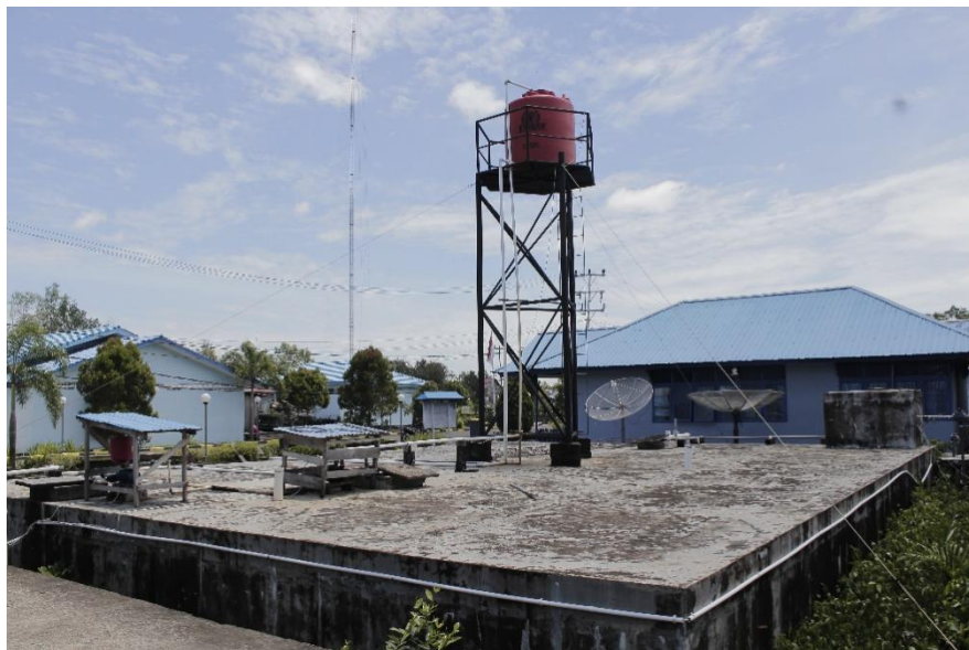
Gambar 23. BAK PENAMPUNGAN AIR
