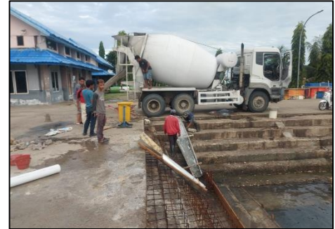
Gambar10. Proses Pekerjaan Rehab Dermaga Stairlanding
