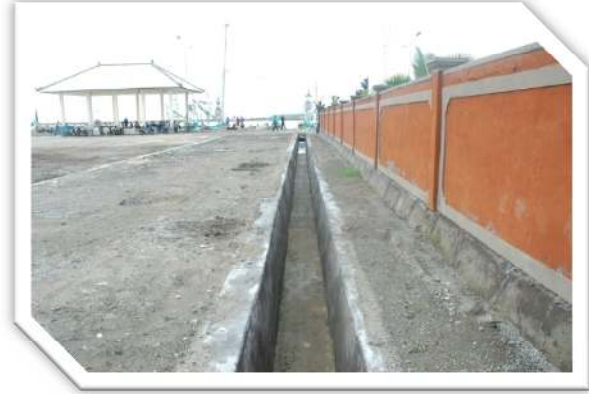
Drainase Jalan Pelabuhan
