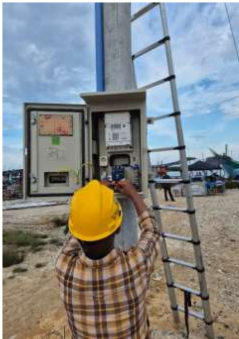
Gambar 7. Pembuatan Instalasi Listrik Darat
