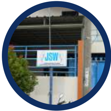
PT Jaya Semangat Wirabahari Cold Storage, dan pabrik es
