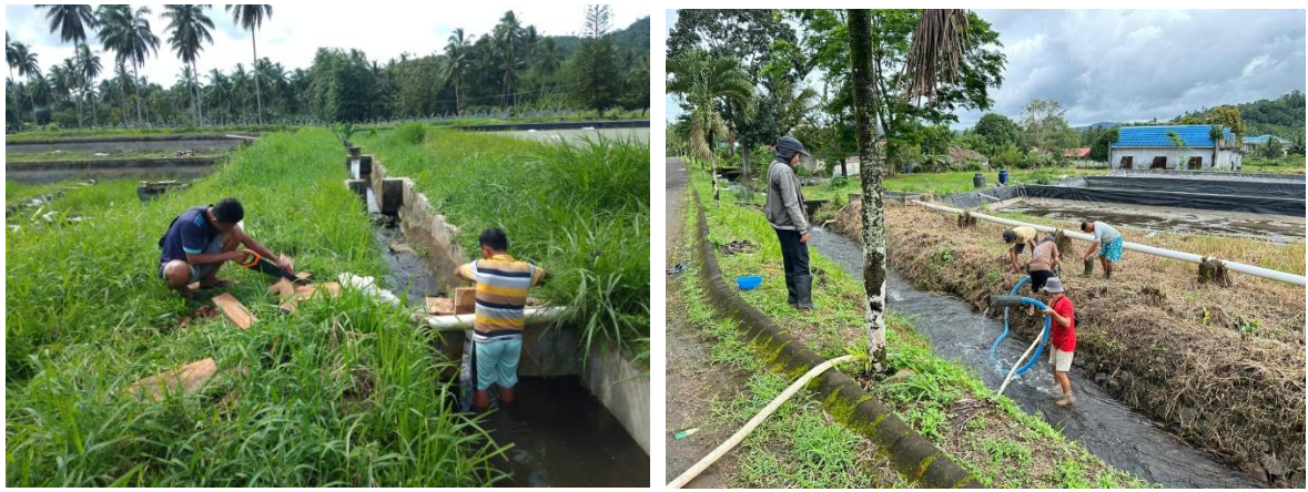
Gambar 7 perbaikan- perbaikan sarana dengan SDM yang ada
