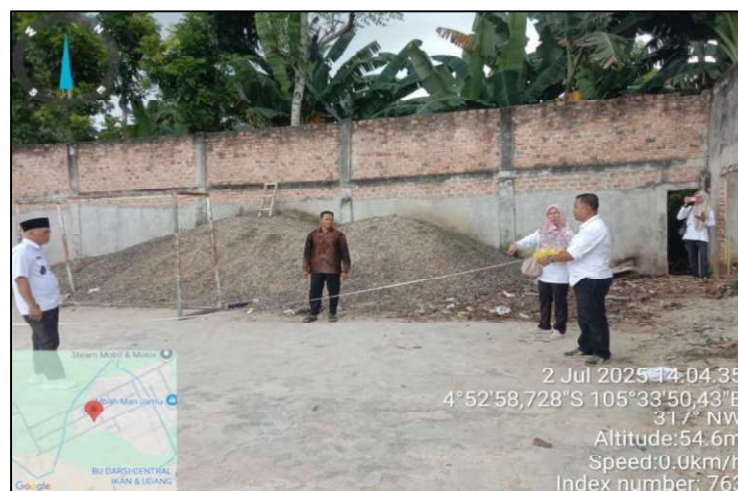
Gambar 3.4. Pengukuran lahan untuk lokasi pembangunan bioflok
