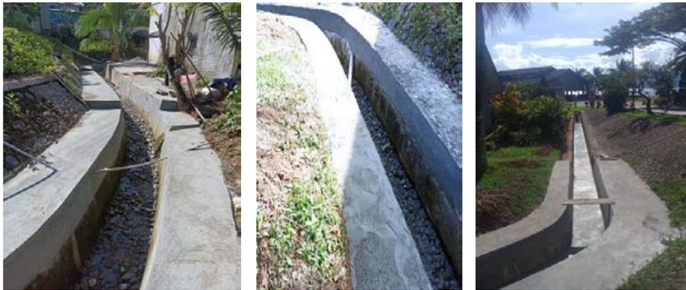
Gambar 42. Pekerjaan Rehab Drainase
