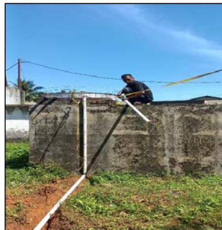
Gambar 44. Perbaikan Pipa Instalasi Air
