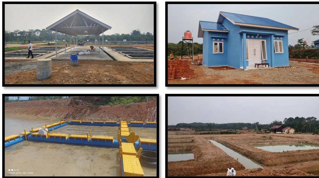
Gambar 20. Pembangunan Prasarana di IPIM TA. 2023
