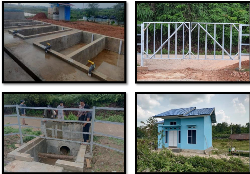
Gambar 19. Pembangunan Prasarana di IPID TA. 2023
