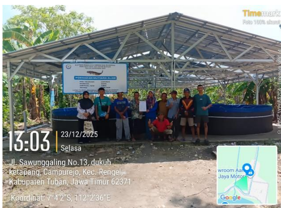
Sarana dan prasarana bioflok di Pokdakan Mutiara Alam Kab. Tuban
