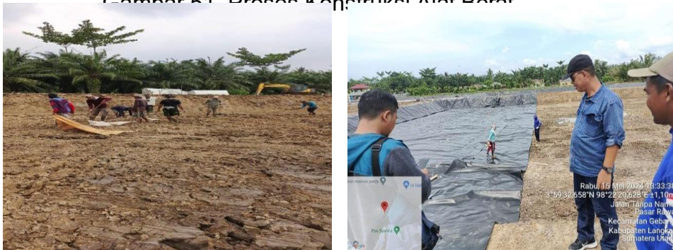
Gambar 52. Proses Pemasangan Pelapisan Plastik HDPE
