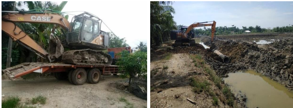
Gambar 51. Proses Konstruksi Alat Berat
