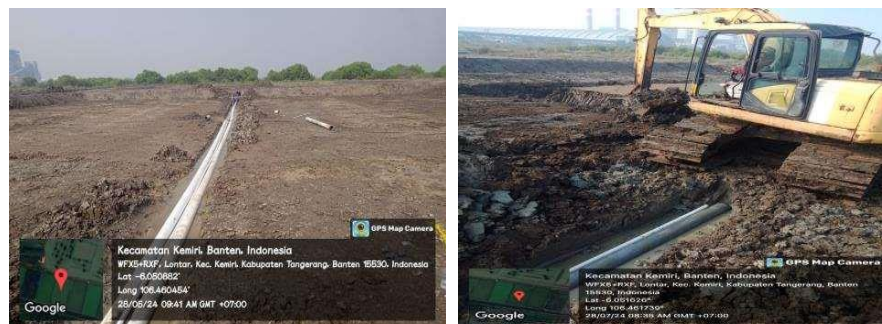
Gambar 43. Proses Pemasangan PIPA PVC
