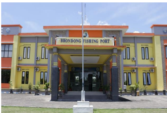
Kantor Utama/ Gedung Pelayanan Terpadu
