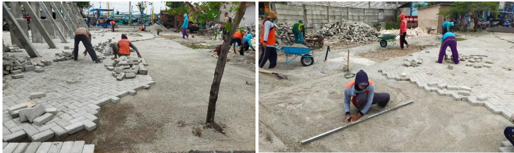
Gambar 12. Rehabilitasi Parkir Motor
