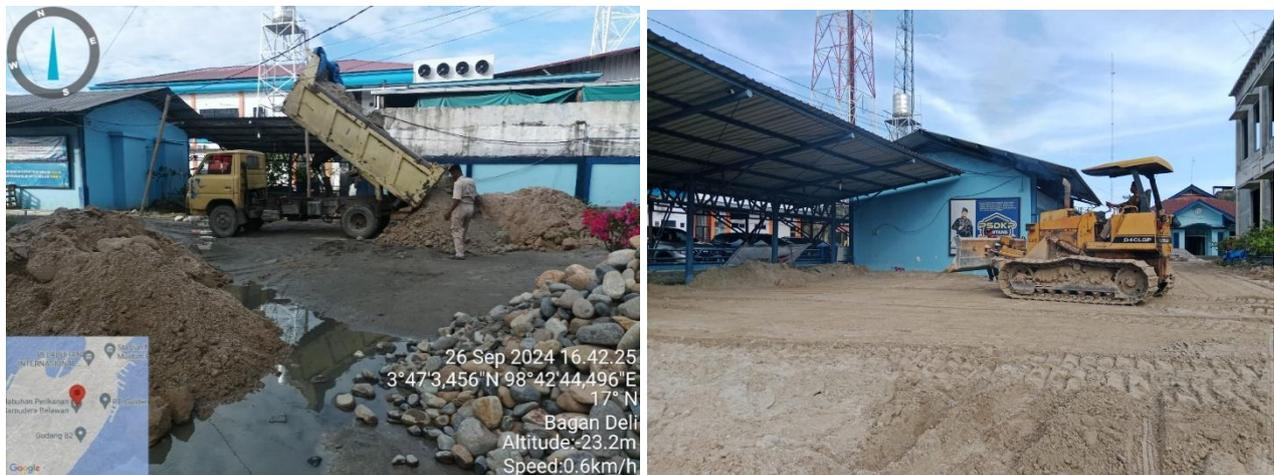
Gambar 13. Material tanah timbun dan batu kali dan perataan material tanah timbun
