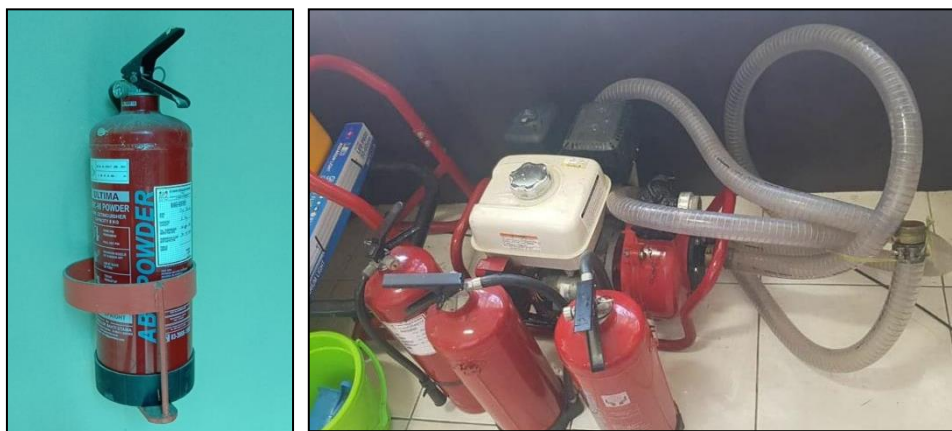
Gambar 10. Alat Keselamatan Kerja di Pelabuhan Perikanan.
