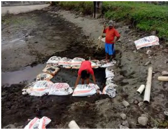
Gambar 24. Gambar Perbaikan Kobakan Kolam Pendederan
