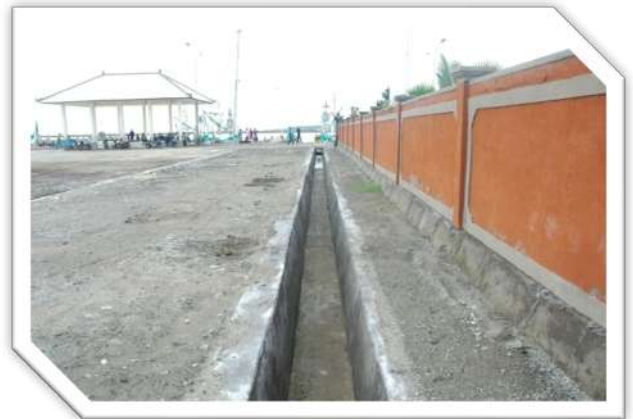
Drainase Jalan Pelabuhan
