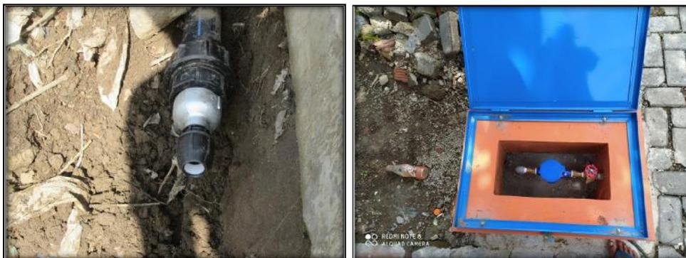
*Gambar 2.3.1.2 Rehab Jaringan Air Bagian Timur dan Bak Kontrol Meter air*
