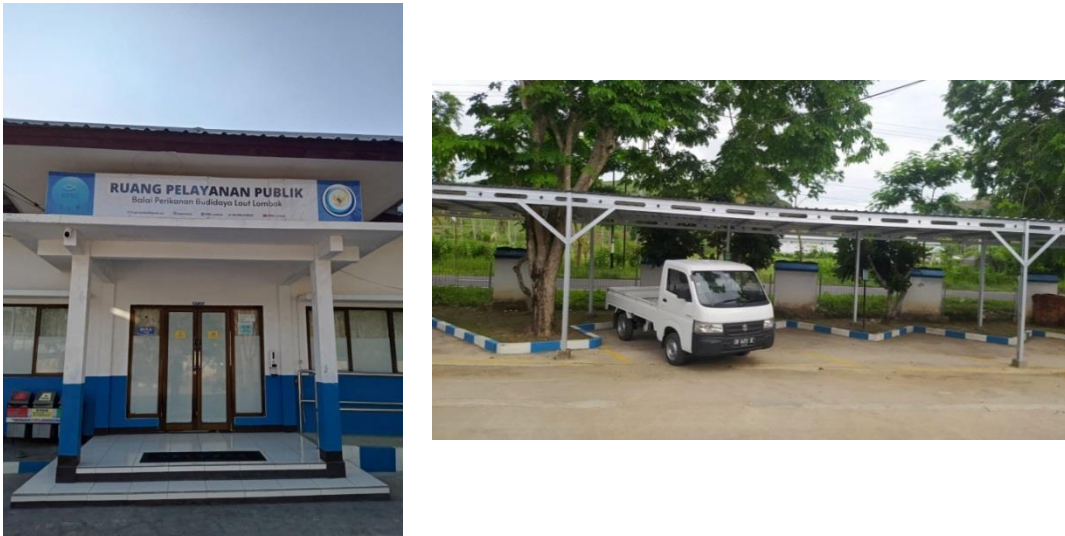
Gambar 8. Area Parkir yang dilengkapi CCTV menghadap area Parkir
