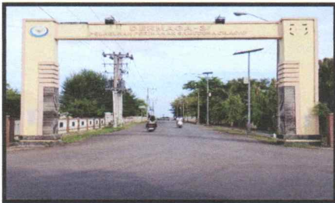
17. Pembangunan jalan akses pelabuhan bagian selatan
