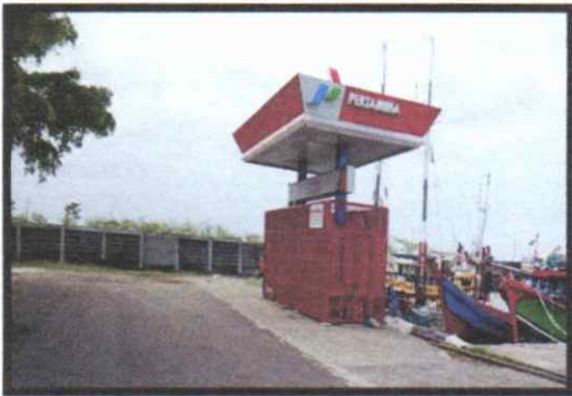
16. Pembangunan SPDN 2 pompa
