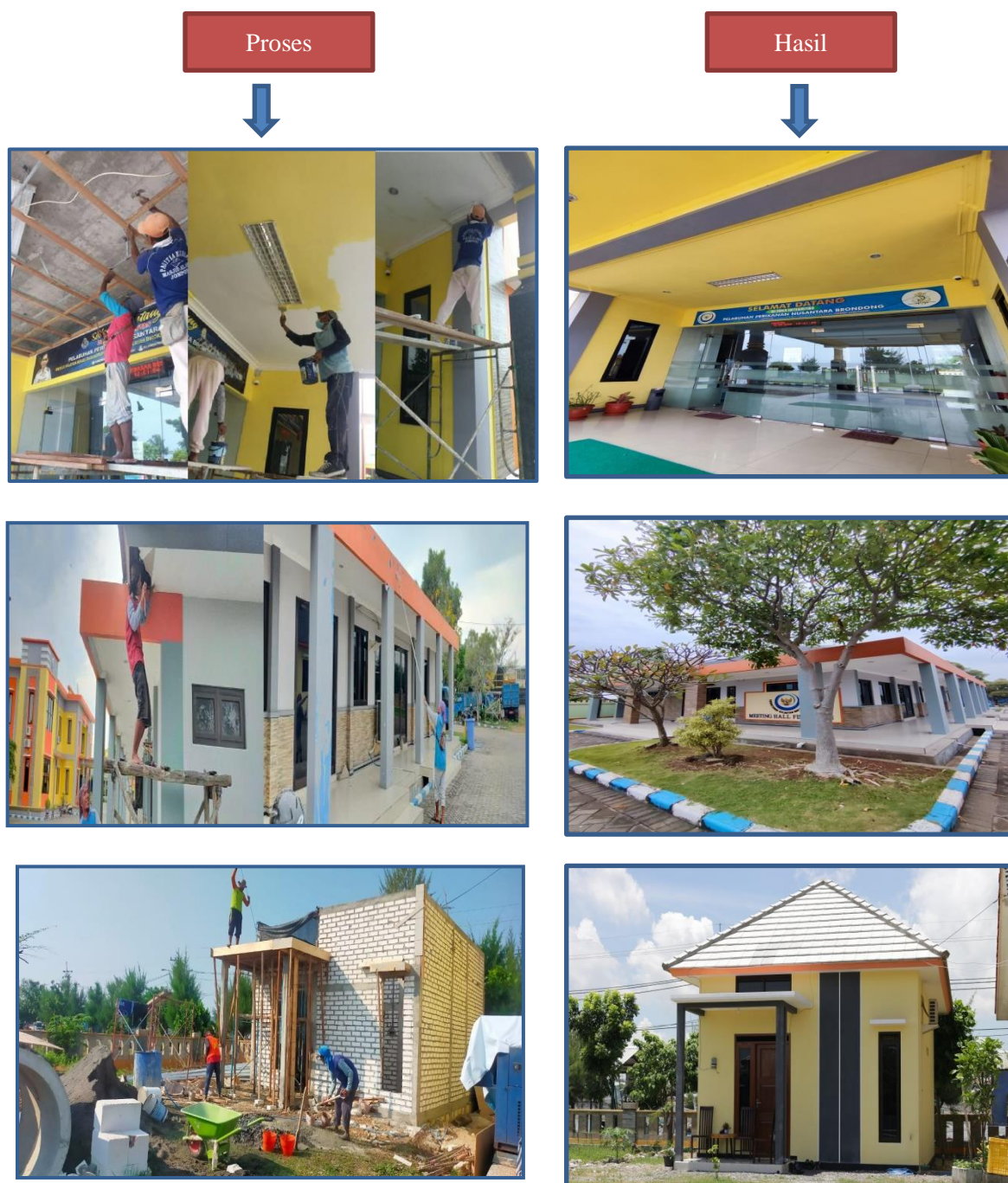
Gambar 25. Dokumentasi Pengembangan Fasilitas di PPN Brondong
