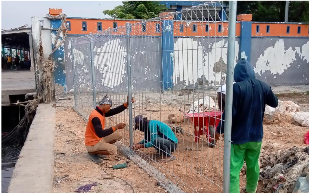
Gambar 13 Pembangunan BRC Utara
