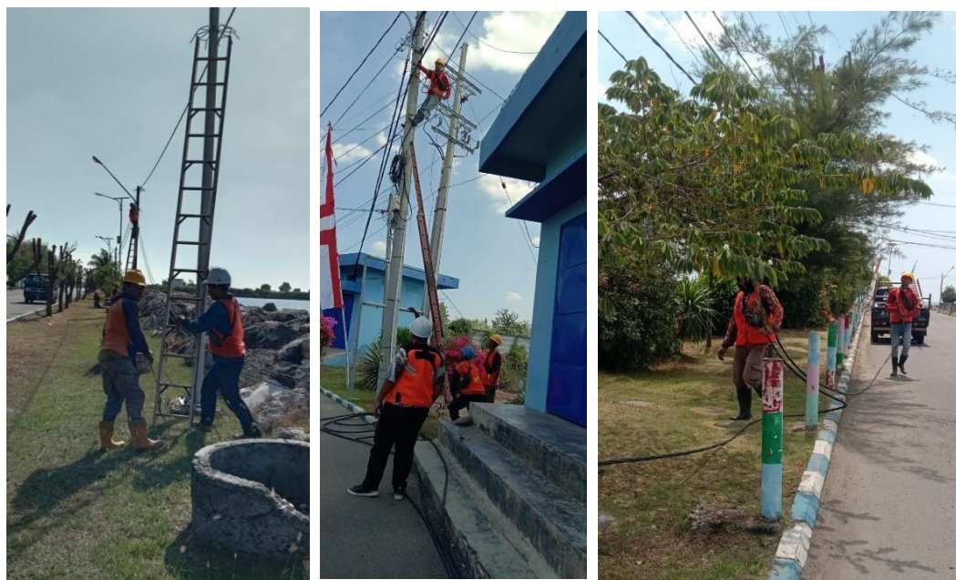
Gambar 12. Rehabilitasi PDU Pelabuhan
