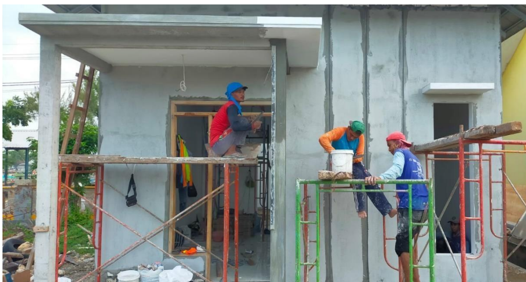
Gambar 11. Pembangunan Mess Operator Pelabuhan
