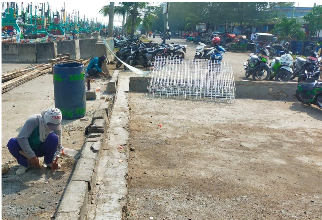
Gambar 14. Pembangunan BRC Selatan
