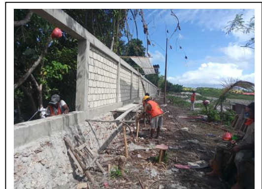
Pekerjaan Pagar Kawasan PPN Tual
