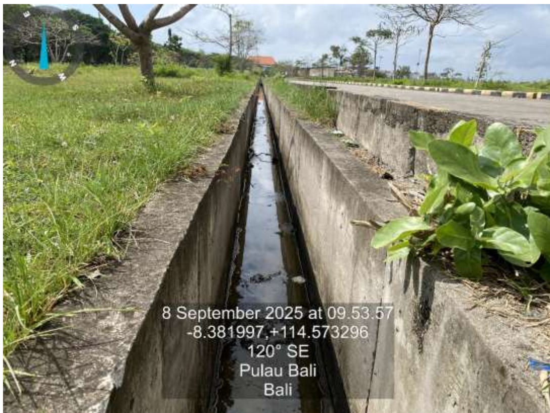
Drainase Jalan Beton Barat 2
