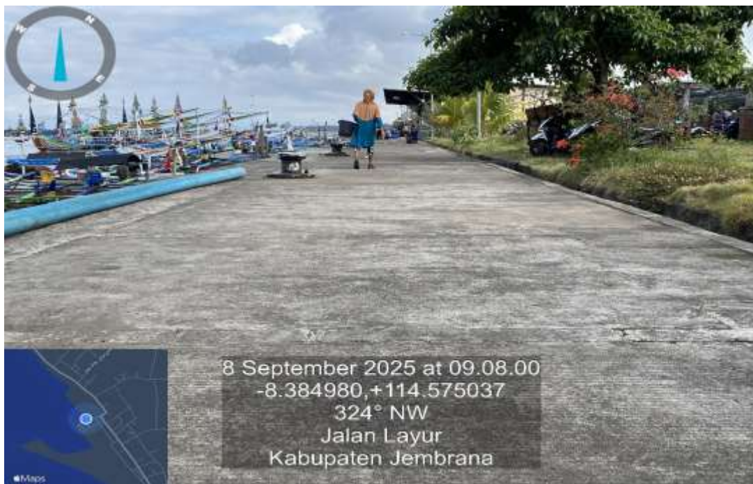
Jalan Beton Turap dan Sekeliling TPI Higienis
