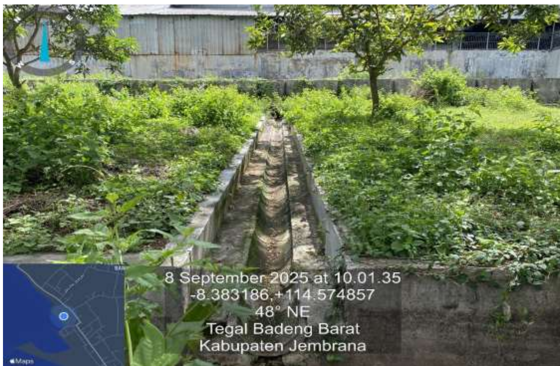
Drainase dari Selatan Pabrik (Utara Cold Storage)
