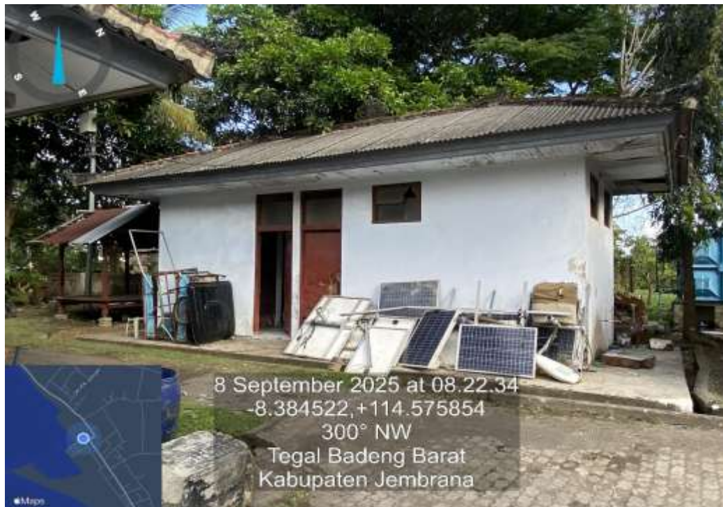
Gedung Toilet Mess
