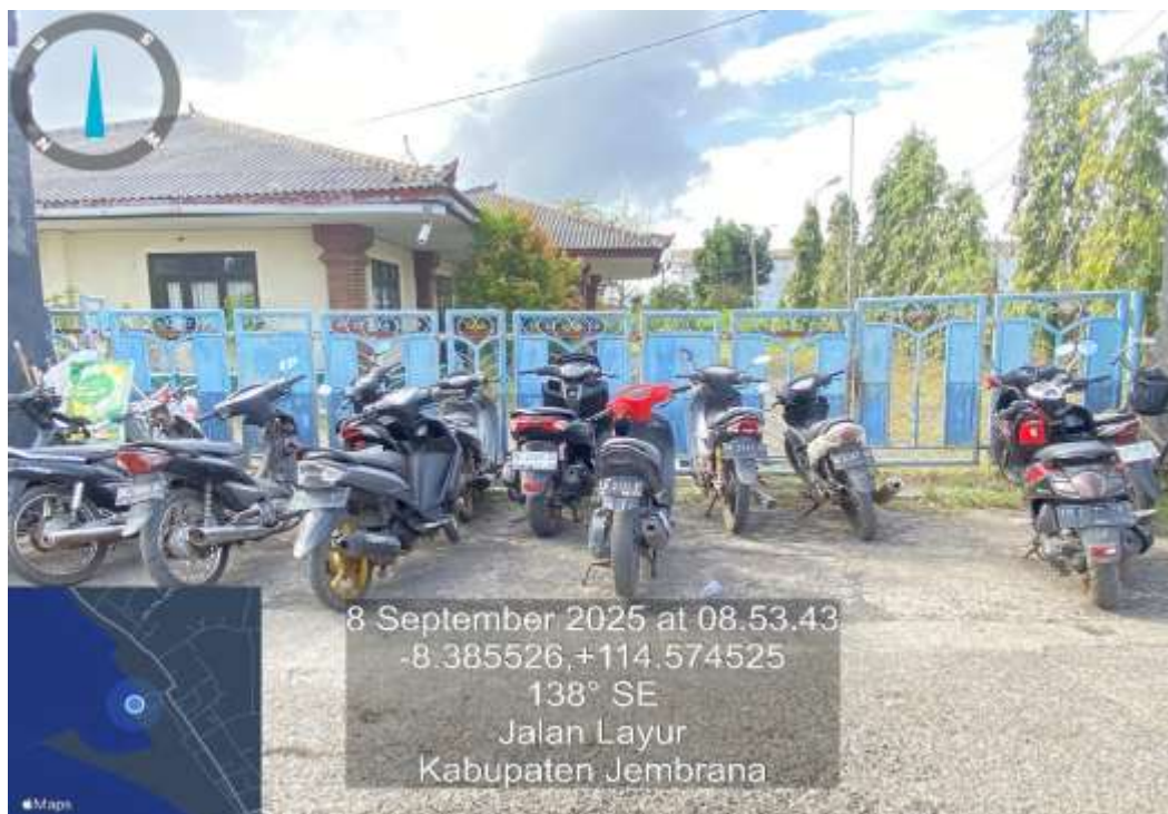
Pagar Besi Pintu Lama
