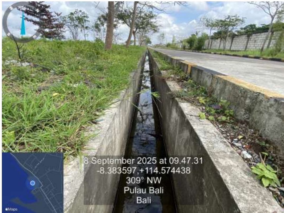
Drainase Jalan Beton Barat 1
