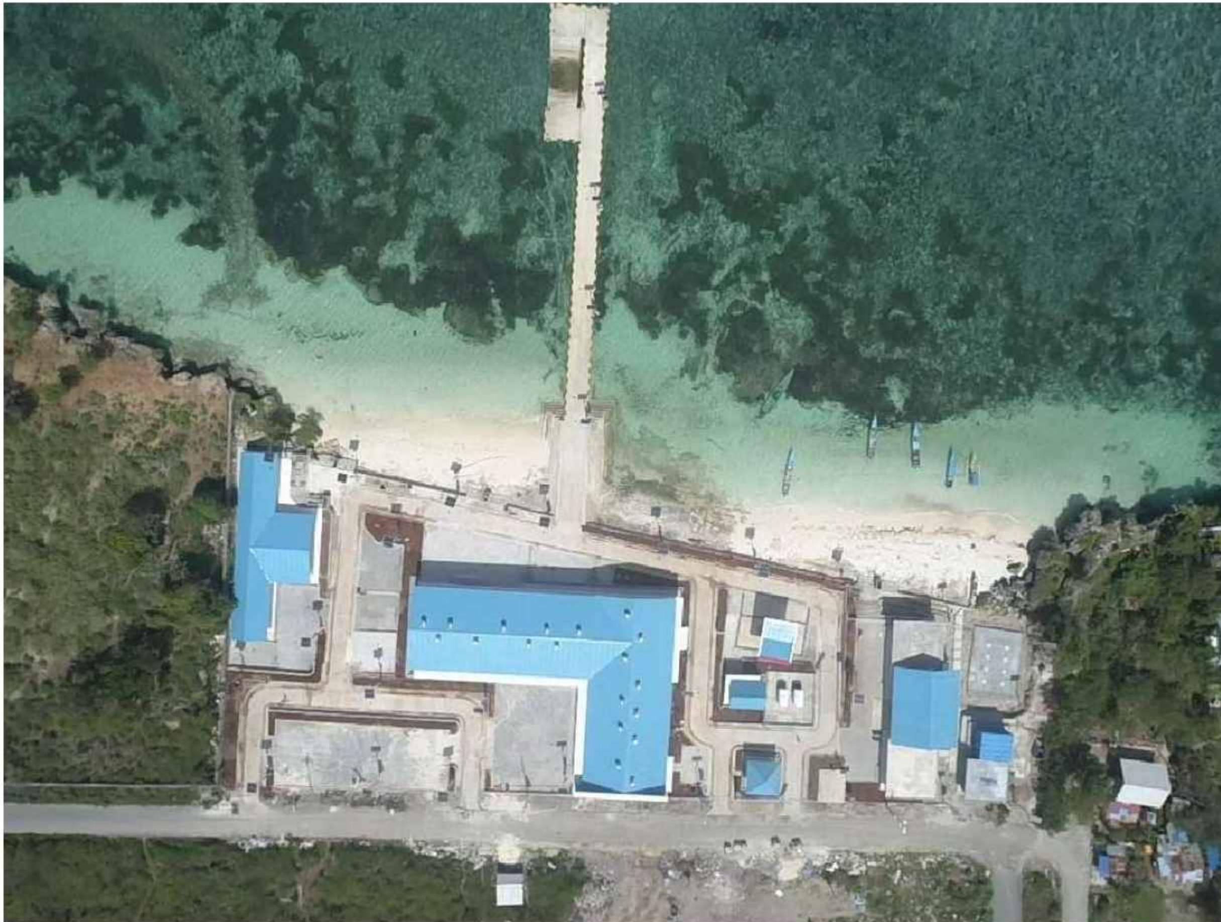
FOTO CITRA LOKASI PERENCANAAN SEAWALL PERENCANAAN PERKUATAN STRUKTUR SEAWALL DI TAMAN SKPT MOA
