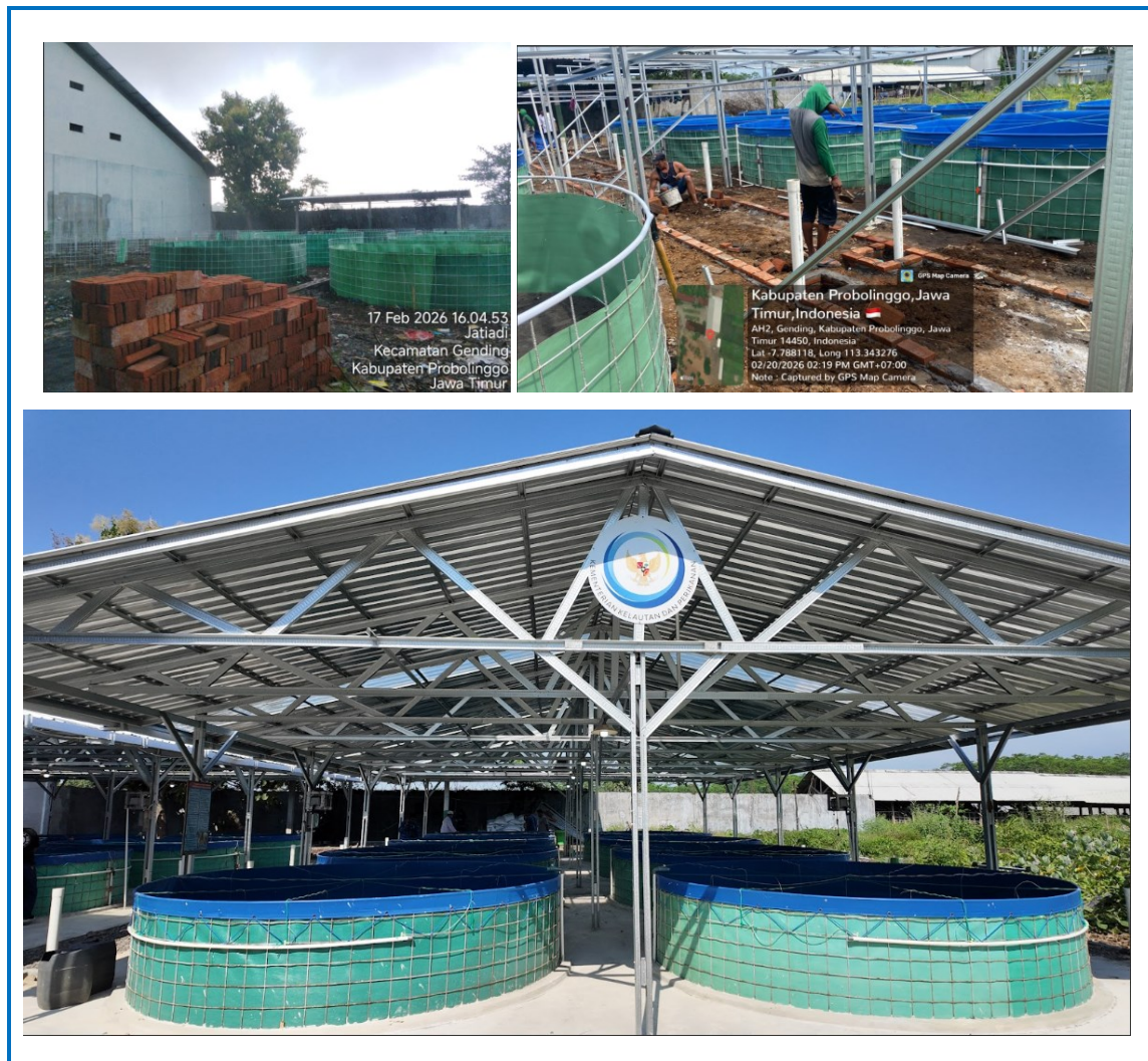
Gambar 18. Proses Pembangunan Kolam Bioflok di Kab. Probolinggo
